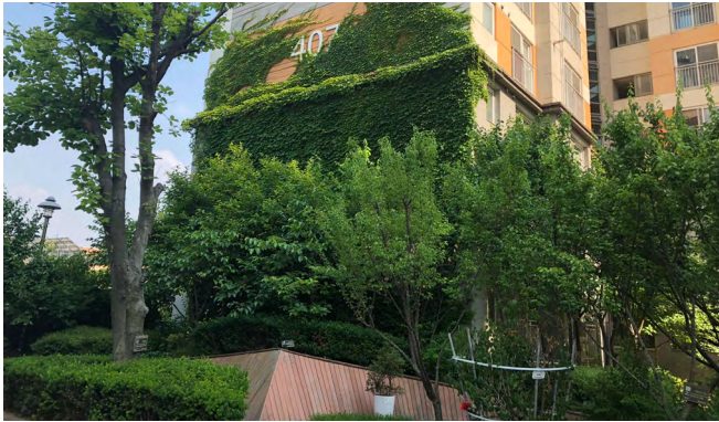
벽면 수직녹화 시범시공
